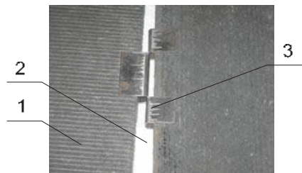
1 – асбестоцементные листы; 2 – теплоизоляционные плиты; 3 – кляммер.
