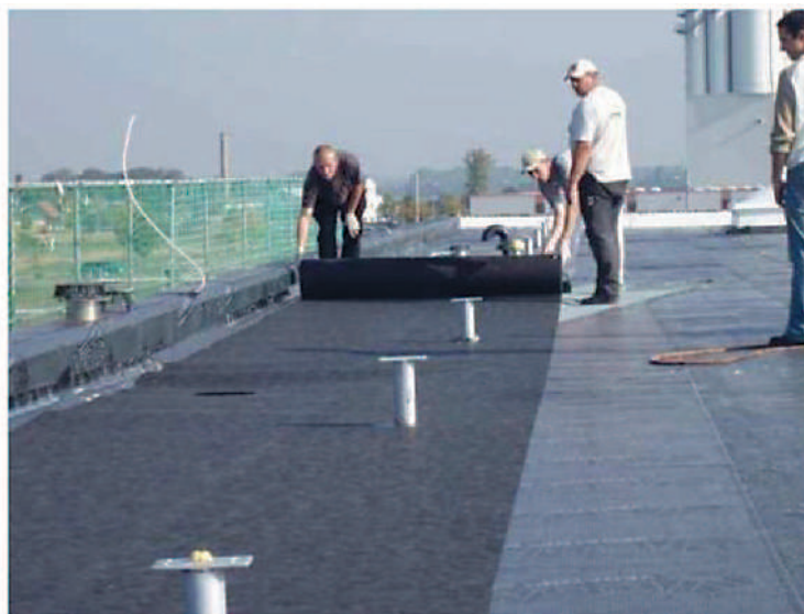
Рисунок Ш6 – Установка электропроводящего слоя
