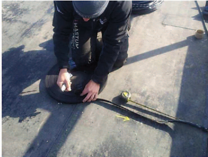
Рисунок Ш5 – Установка предварительно собранных MPLE индикаторных кабелей
