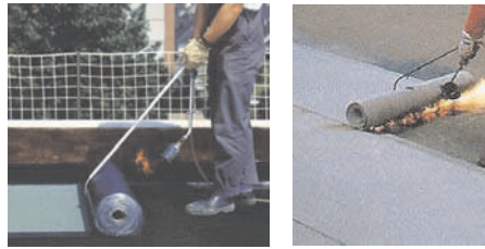
Рисунок 3.11 - Использование захвата-раскатчика при наплавлении
