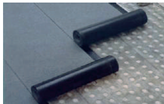
Рисунок 2.11 – Устройство вентиляруемой кровли с применением материала KTROOF PERFOR
