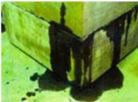
Протечки сквозь бентонитовые шнуры.
